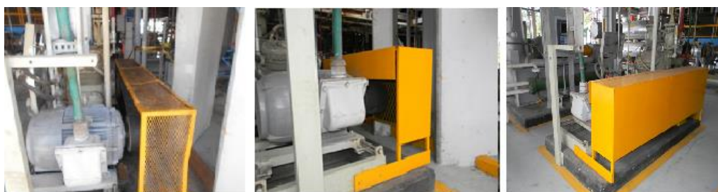
Figura 35. Guarda de banda en sistema de refrigeración de etilenglicol ubicado en el local No productivo de Calderas y Energías antes y después de la implementación de las auditorías 5'S.
