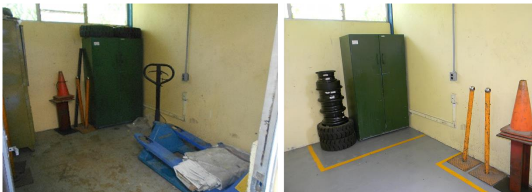
Figura 34. Cuarto de contratistas del local No productivo de Mantenimiento antes y después de la implementación de las auditorías 5'S.
