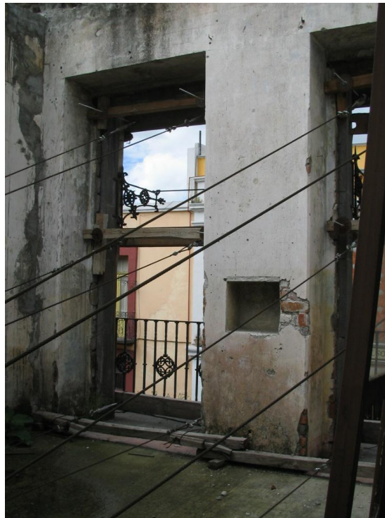
Vista, interior de habitación principal central planta alta
