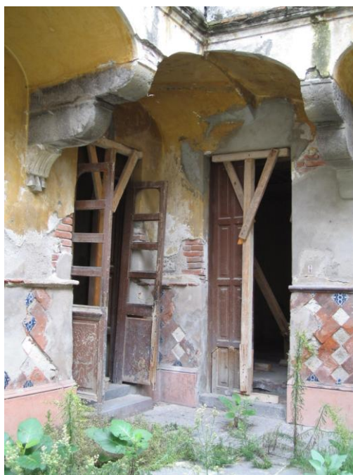
Vista, desde patio central hacia accesos a habitaciones
