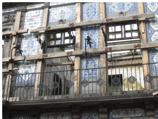
Detalle de fachada apuntalada
