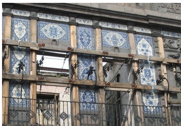
Fachada del segundo nivel Archivo del autor.
