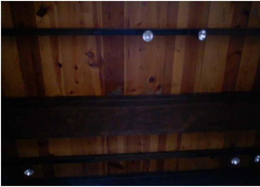
Nuevas techumbres y vigas de acero
