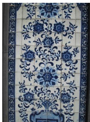
Detalles de la fachada.
