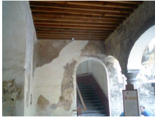
Intervención al Inmueble
