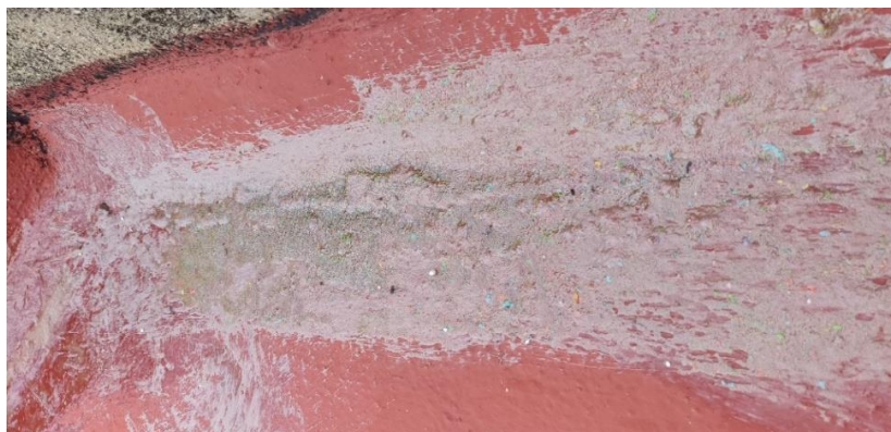
Figura 3.15 Aplicación del impermeabilizante de Unicel reciclado.
