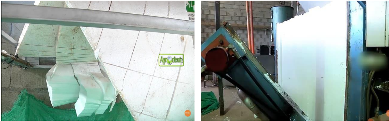
Figura 4.5 Corte de material y compactación por vapor
