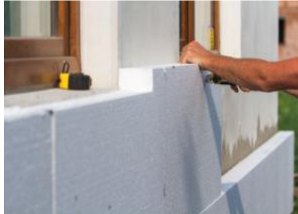
Figura 3.9 Unigel en la construcción.
