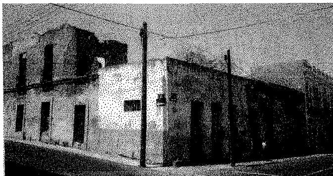
Edificio abandonado en el barrio de la Luz ( 2 Ote y 12 norte), este edificio bien podría albergar algunas viviendas.
