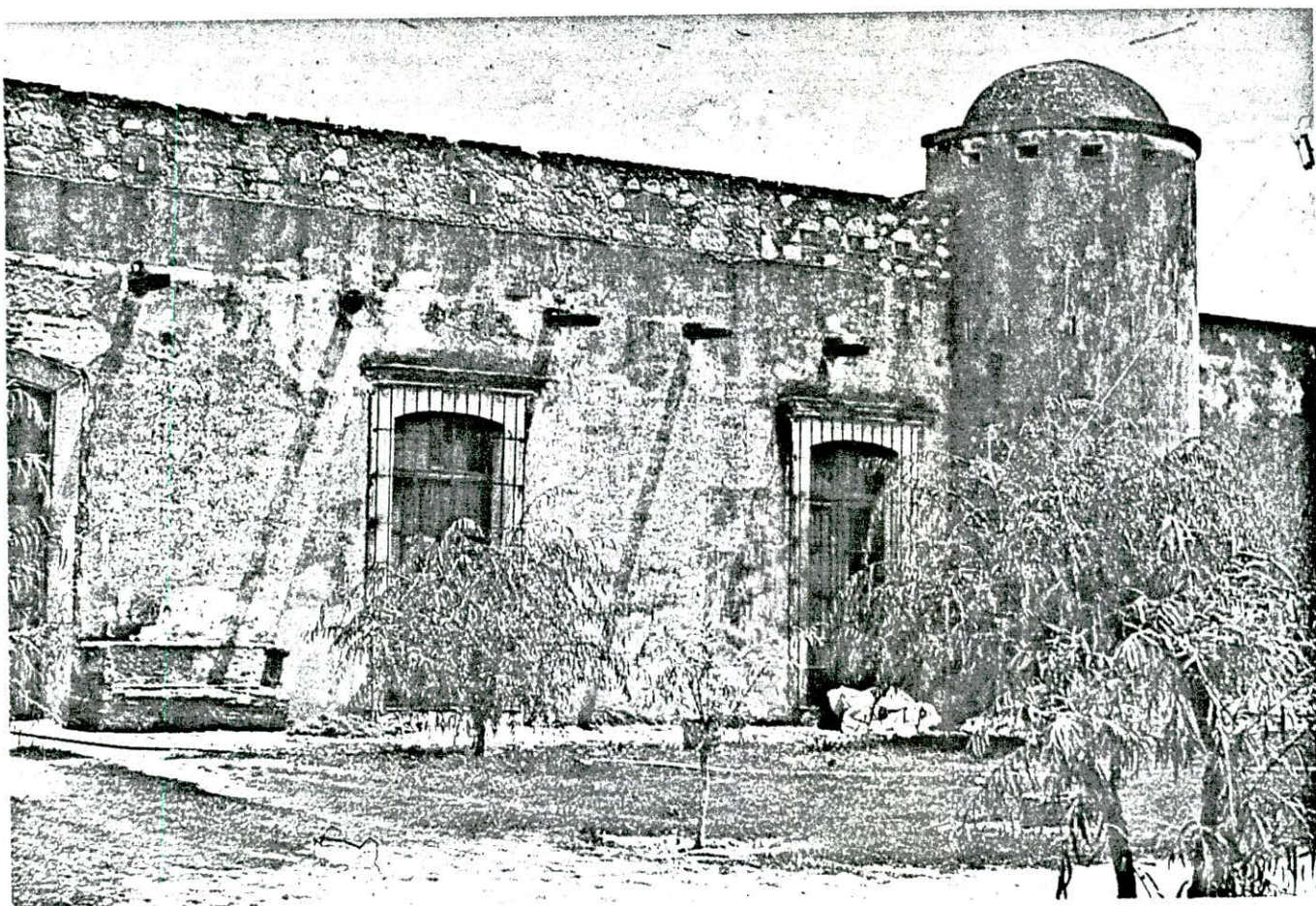
Este torreón de vigilancia de la hacienda San Cristóbal Lagunas le da al lugar un aspecto de fortaleza
