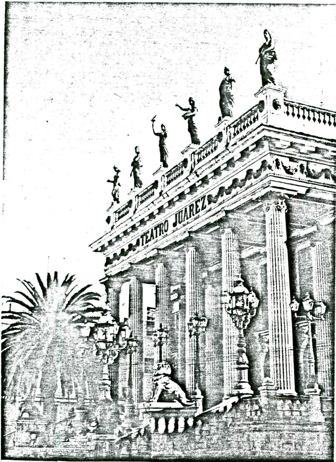
El Teatro Juárez de la ciudad de Guanajuato fue obra de los arquitectos José Noriega y Antonio Rivas Mercado. Es una obra clásica del Porfiriato en la que tuvo auge el estilo ecléctico. El edificio presenta un pórtico de columnas, rematado por ocho esculturas. En su interior tiene influencia mudéjar.
