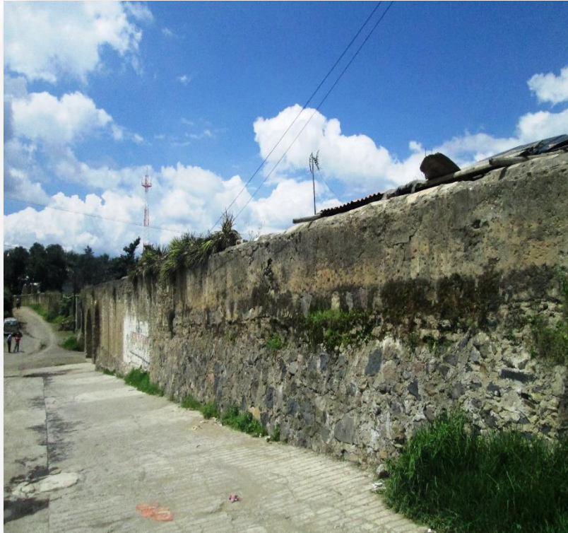
• CAÑO (SECCIÓN 2) – Hacia arcada
