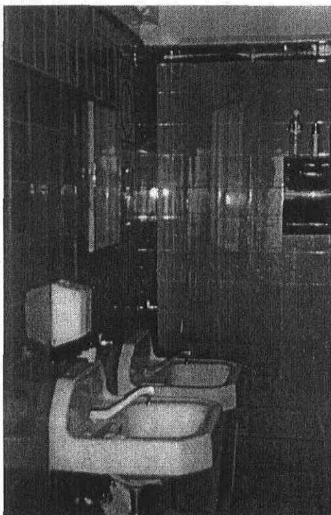
Servicios Sanitarios Originales
