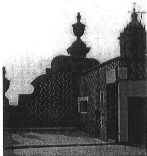
Vista de Remates en Azotea
