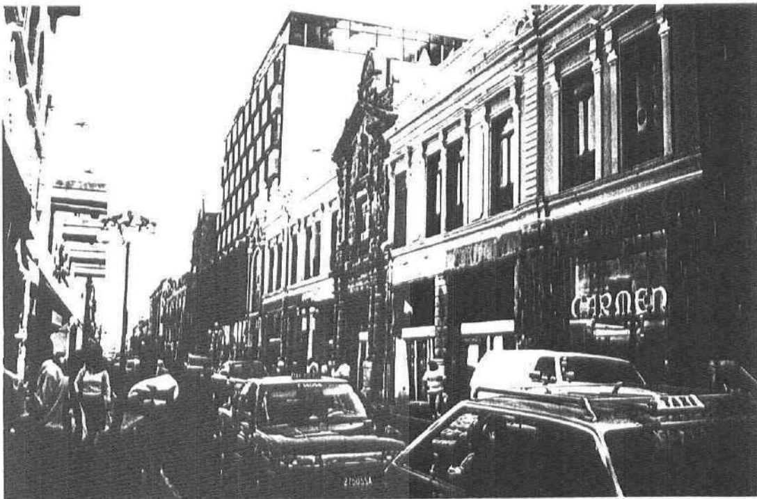
La contraposición del funcionalismo en el Centro Histórico. (Edificio del Hotel Gilfer)
