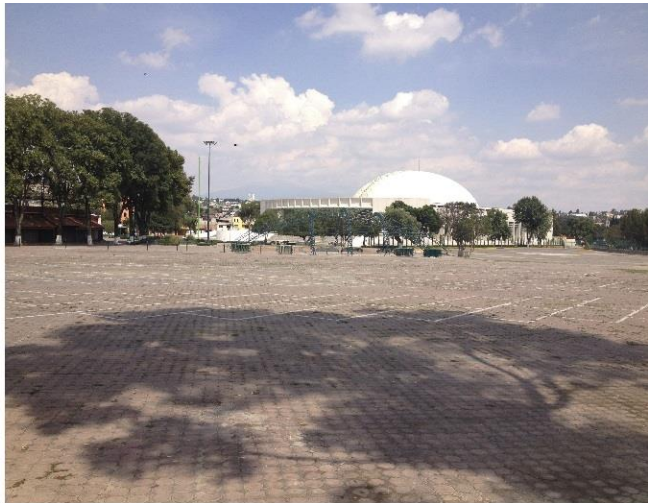
Zona de estacionamiento del recinto ferial.
