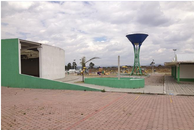
Explanada que conecta al área de exposición, con la zona comercial.
