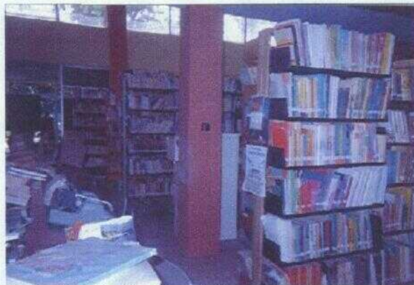
Fig. 4.- Ventilación e iluminación cenital para salvar la estantería de los libros.
