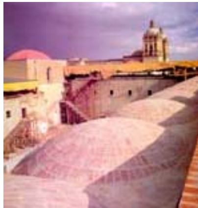
Fig.b-Vista de los extrados de las bóvedas.
