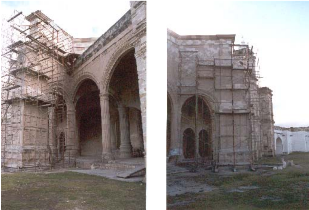
Trabajos de conservación y restauración en apoyos de la capilla abierta en Teposcolula Oaxaca . / Nov. 2003
