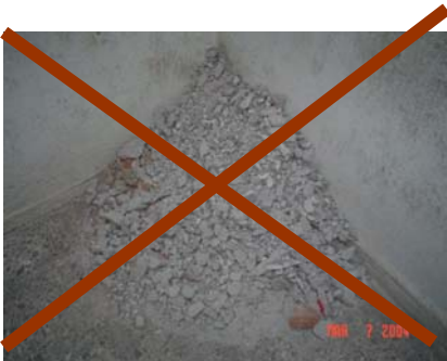
Procurar que al realizar el mantenimiento del templo, no se utilicen espacios dentro del conjunto para depositar escombros y basura.
