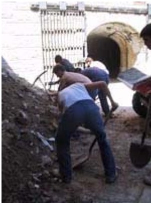
Retiro de escombros y basura por medio de traspaleo y carretilla, para dar un mejor aspecto al templo.
