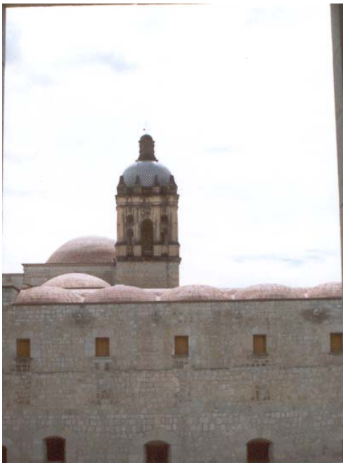
Bóvedas restauradas del claustro del Ex convento de Santo Domingo Oaxaca./ Nov. 2003
