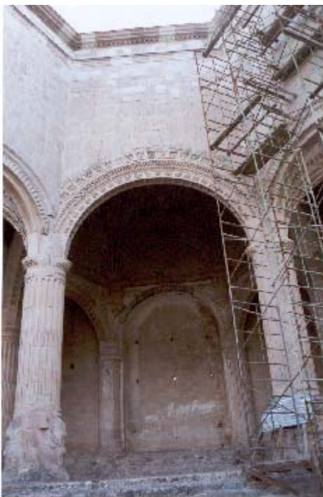
Vista del altar y una de las naves de la capilla abierta. Las cuales llevan trabajo de restitución y consolidación de materiales. Conservación de pintura mural en arranque de la cúpula. /Nov. 2003
