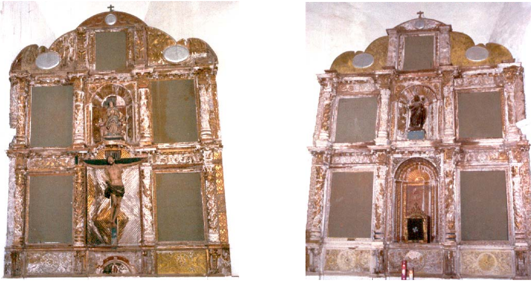
fig.5-retablos colaterales . Dañados por las anteriores intervenciones. / Dic. 2003
