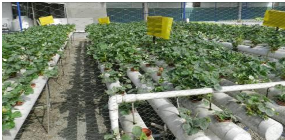
Foto no.4 Canales de PVC en el CIHNM La Molina
