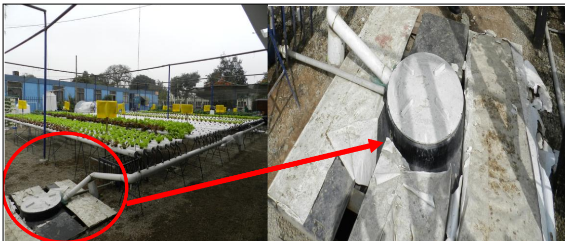
Foto no.3 Tanque colector
