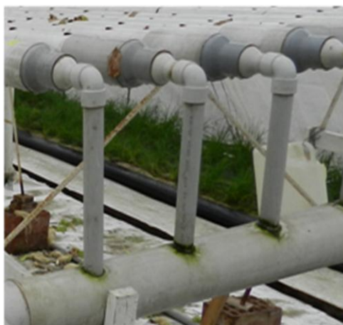
Foto no.15 Material PVC
