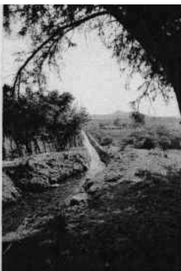
Acequia en el extremo norte del acueducto de San Lucas Matlala.
