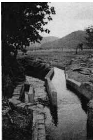
Partidor en el extremo sur del acueducto de San Lucas Matlala.
