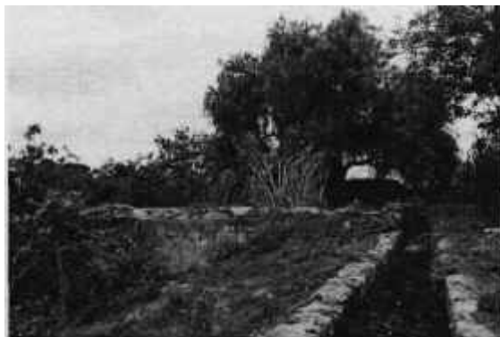
Acueducto que suministra la ciliarra del molino de San Lucas Colotzingo, Tochimilco.
