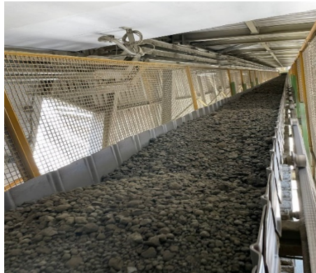
Figura 3.2. Banda transportadora de Clinker.
