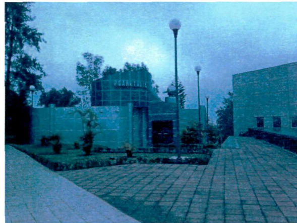
Foto.2 Vista del planetario desde el vestíbulo principal
