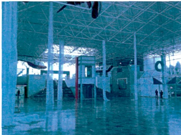
Foto.3 Vista de la plaza de distribución desde el área de pequeños
