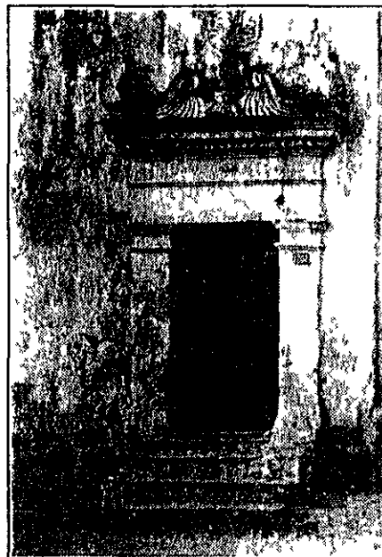
FACHADA DE LA SACRISTIA DE ANALCO.
