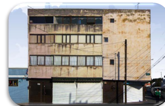
Ilustración 19 y 20 Presencia de humedad, grafiti y falta de aplanados - Acervo personal
