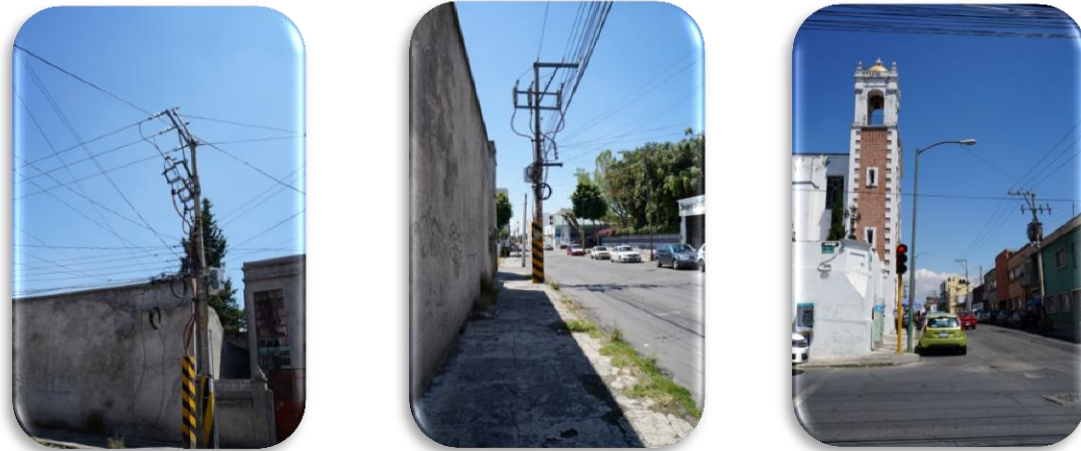
Ilustración 11, 12 y 13 Postes, acometidas y luminarias en la 5 Pte. Acervo personal
