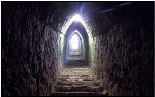
➤ Arco Falso hecho por exploradores dentro de la pirámide
