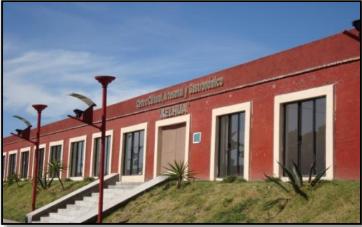
➤ Recinto Ferial Xelhua que delimita al Sur con el parque Soria
