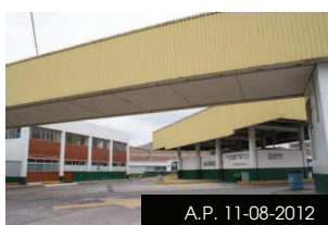
2.41. Se observa el acceso a la zona de baños y estacionamiento de autobuses.
