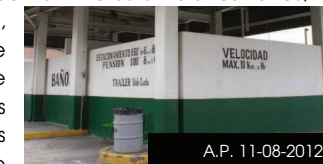
2.46. Se observa la zona de baños con algunos letreros.
