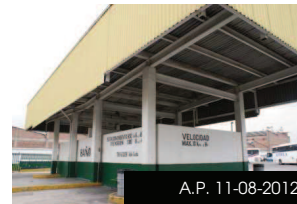
2.31. Se observa la zona de baños en la parte del estacionamiento.
