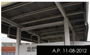
2.43. Se observa una cubierta de lámina soportada por vigas de acero.
