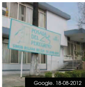
2.76. Se observa la fachada de acceso a la Casa del peregrino “Cáritas”.
