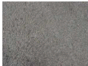
Pavimento de concreto
