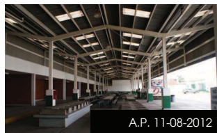
2.45. Se observa la estructura de vigas de acero soportando la lámina del comedor.
