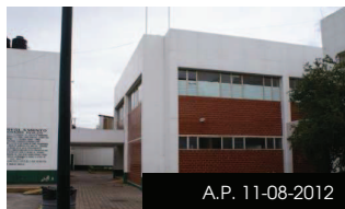
2.44. Se observa la estructura a base de columnas y traveses, con muros divisorios.
