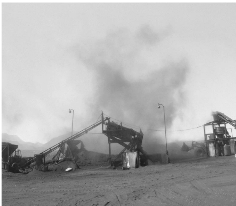
Figura 3.- Planta de beneficio de carbón mineral en operación.
