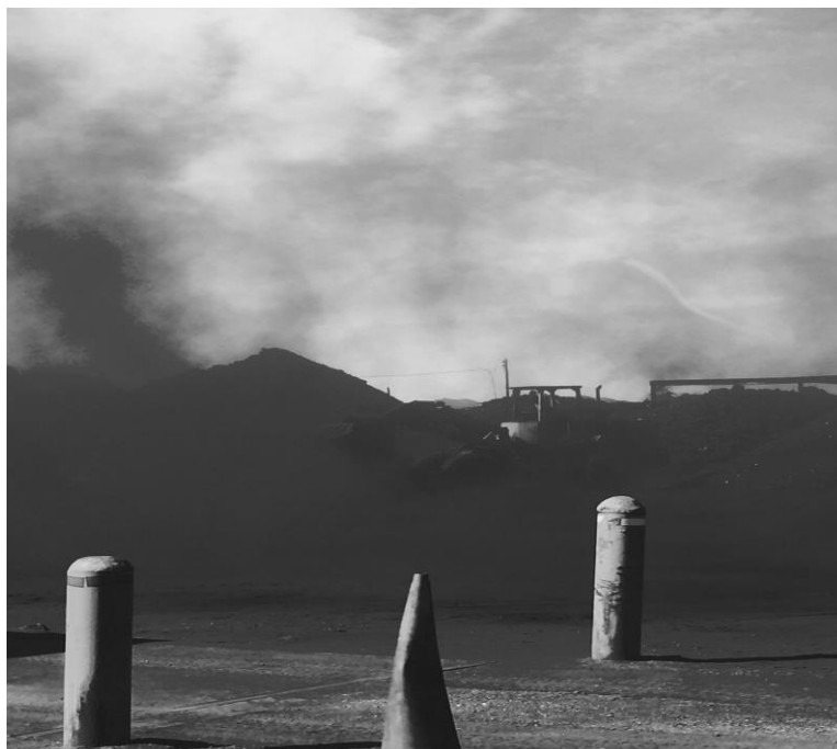
Figura 6.- Planta de beneficio de carbón mineral en operación.
