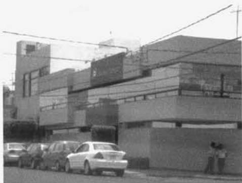
F01. Fachada Principal del Centro de Cirugía Integral
