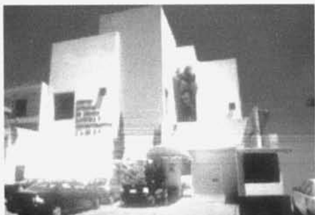
F05. Fachada Principal del Centro Integral de Cirugía Estética y Reconstructiva
