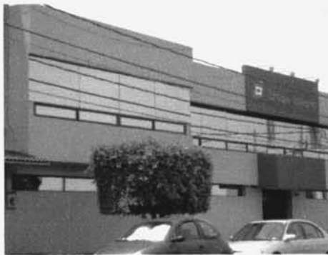
F03. Fachada Principal del Centro de Cirugía Integral
