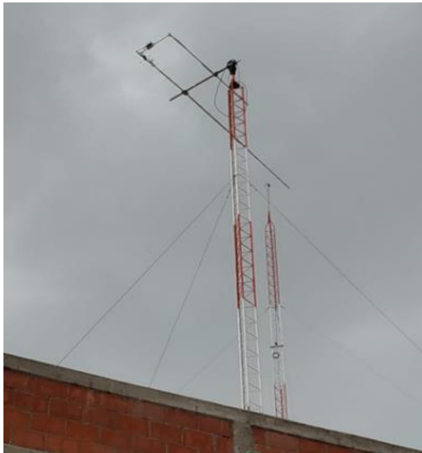
Figura 5.15. Antena 436CP42UG montada en UPAEP
