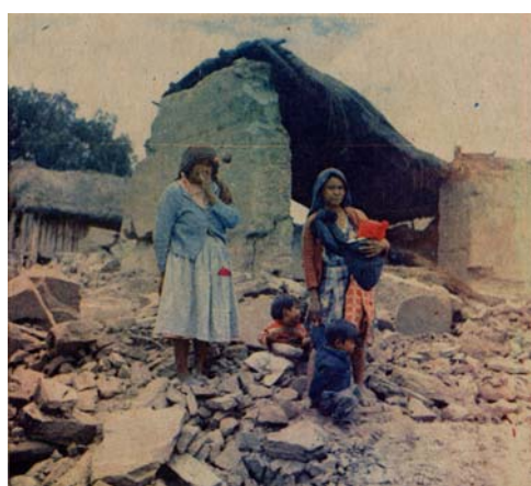
Quecholac después del sismo de 1973. El Sol de Puebla , 29 de Agosto de 1973, OEM, Puebla, Pue.
