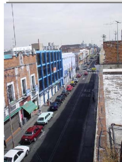
IMAGEN 11: Vista Norte de la Av. 16 de Septiembre. Zona de Monumentos, ciudad de Puebla. Fotografía de Ana Karina Silveti Ortega. Febrero 2004.
