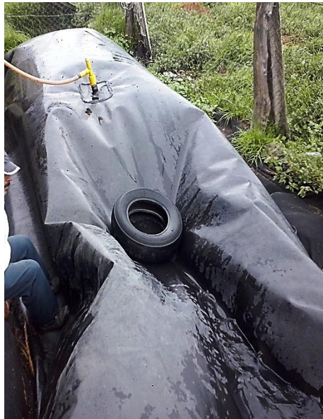
Figura 4.11: Biobolsa de 20,000L Fuente: Propia
