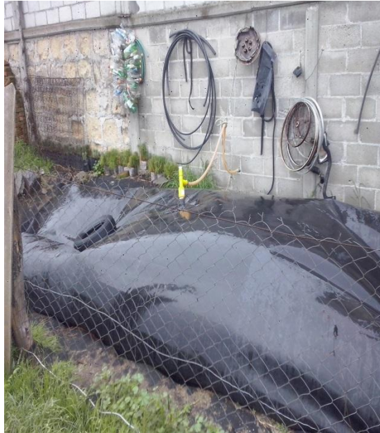
Figura 1.3: Biodigestor 20,000 L. Fuente (propia)
