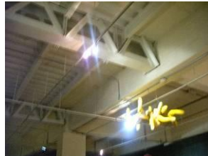
Estructura de acero en salas de exposición
