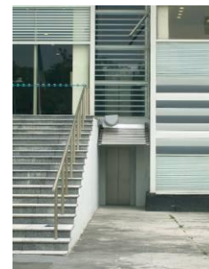
Detalle de fachada
