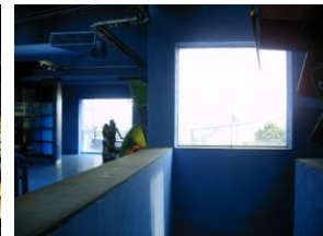
Aberturas en los muros
