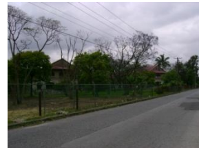
Vistas de la calle sur 33 del asilo Mier y Pesado
