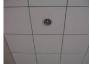
Falso plafón en vestíbulo
