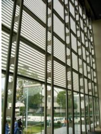
Estructura de acero que soporta el cristal
