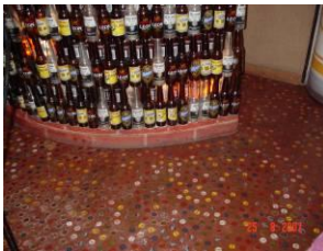
Colado de concreto con corcholatas incrustadas
