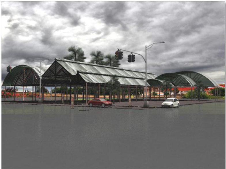
Vista 1 de la cubierta del mercado.
