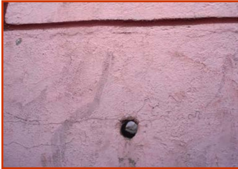
F.66 Detalle del desagüe de las gradas hacia el ruedo. A.P. 04/2007
