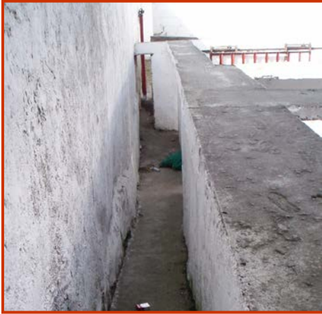
F.28 Pasillo que comunica el área de desembarque con los toriles. A.P.02/2007
