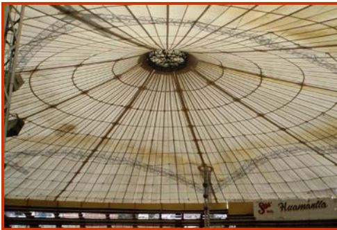
F.24 Cubierta. A.P.02/2007
