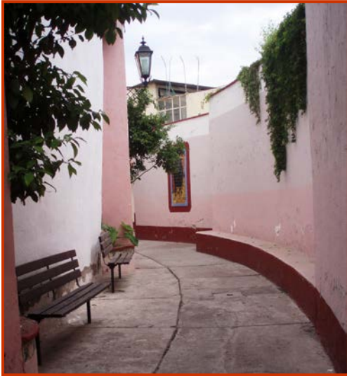
F.68 Corredor exterior que circunda la plaza. A.P. 04/2007
