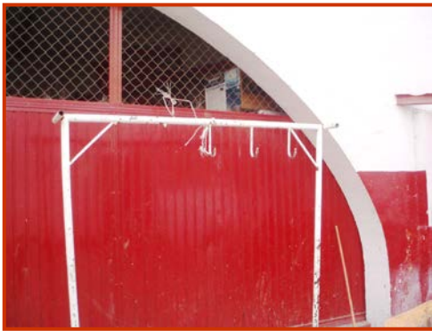
F.64 Ganchos para los canales. A.P. 04/2007
