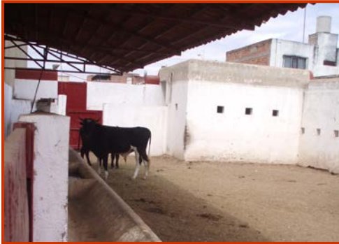
F.59 Vista de los corrales de cabestros. A.P. 04/2007
