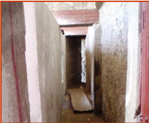
F.19 Acceso al área de toriles y comunicación con el patio de cuadrillas. A.P.02/2007
