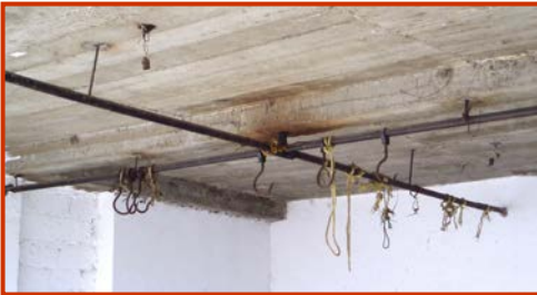
F.18 Área del desolladero. A.P.02/2007
