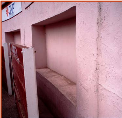
F.67 Vista de los asientos que forman parte de la contrabarrera, situados detrás de los burladeros del callejón. A.P. 04/2007
