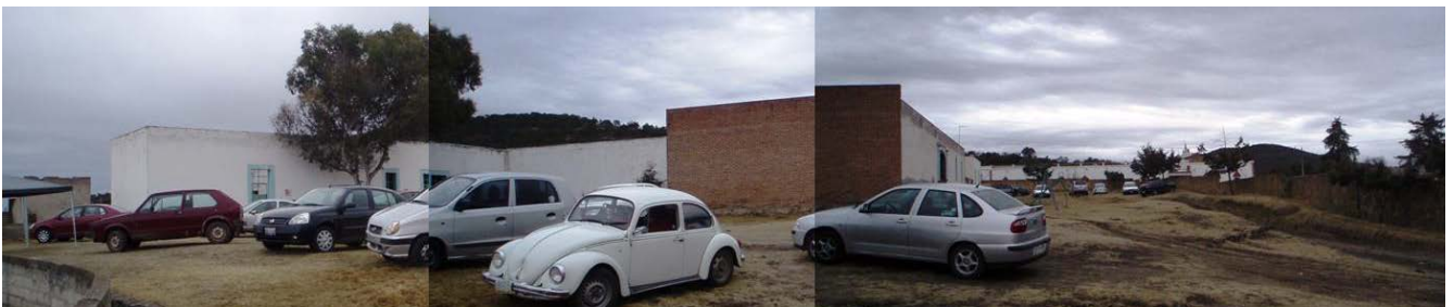
Escuela primaria. Es una construcción que actualmente se encuentra en desuso, la propiedad es de la familia de Haro. Se encuentra ubicada a un costado de lo que fueran los graneros, hoy la casa habitación del dueño.
