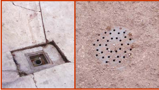
F.63 Coladeras situadas en el área de desolladero. A.P. 04/2007
