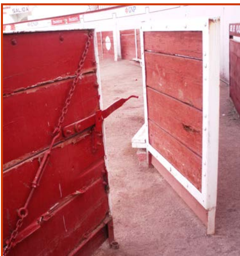
F.65 Detalle de los cerrojos y abatimiento interior de las puertas. A.P. 04/2007
