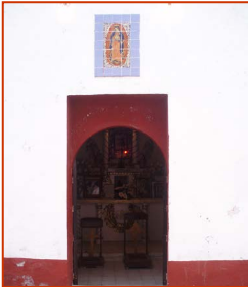
F.48 Vista de la capilla de la plaza. A.P. 04/2007
