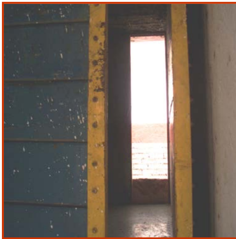
F.52 Cajón de la báscula y la comunicación entre los corrales y el corredor que los distribuye. A.P. 04/2007
