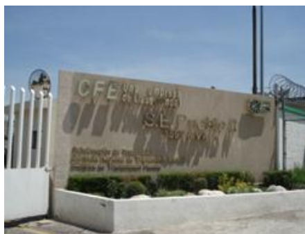
Imagen 72. Acceso de la subestación por la Avenida Resurrección.
