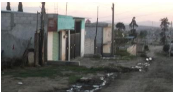
Imagen 10. Calles sin pavimento, ni drenaje, ni banquetas.
