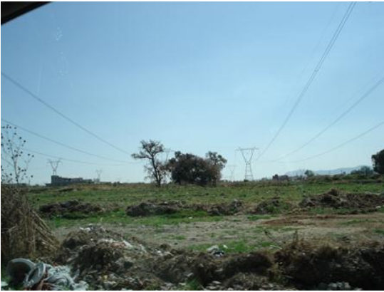
Imagen 60. Vista de cómo es cruzada la Barranca por torres y cables de alta tensión
