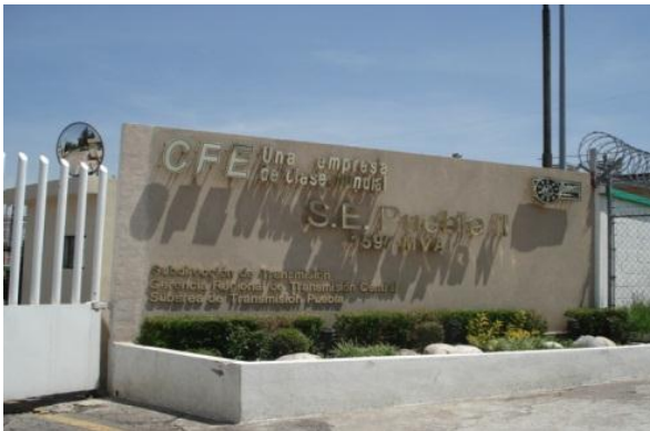
Imagen 95. Subestación Puebla II
