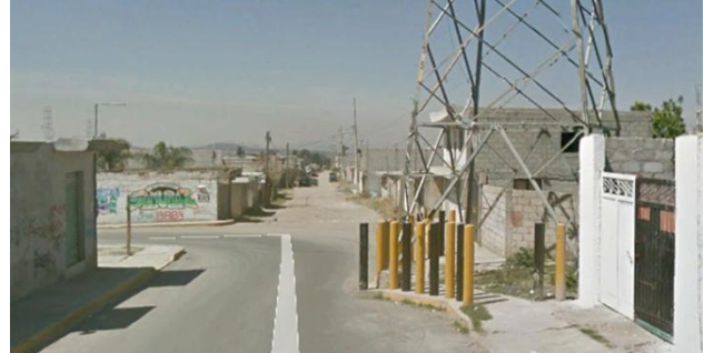
Imagen 84. Invasión de la vialidad a la zona de restricción de la torre de alta tensión.
