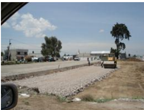
Imagen 69. Construcción de la zona deportiva en el área de la zona arqueológica.
