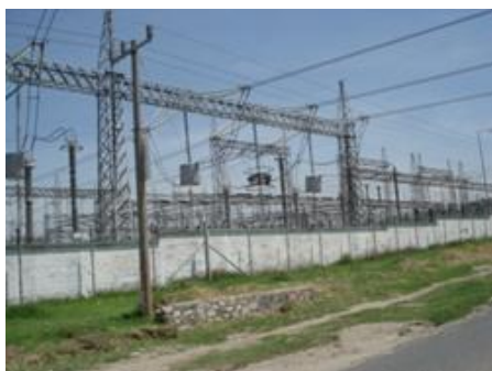
Imagen 71. Área de la subestación que colinda con la colonia hacia el sur.
