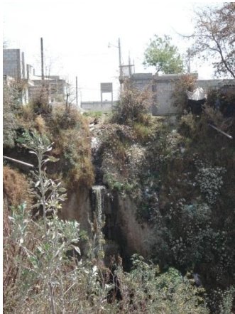
Imagen 62. Aguas residuales contaminando la barranca.
