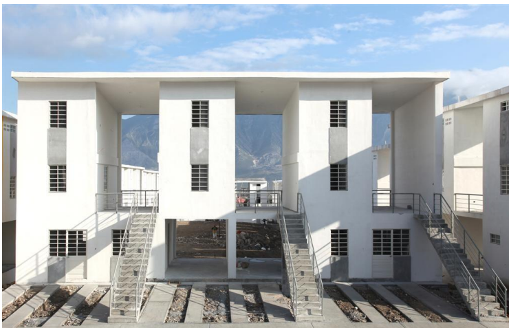
Imagen 6. “Elemental Monterrey” Prototipos de vivienda incremental diseñadas por Alejandro Aravena, Gonzalo Arteaga y Fernando García en Monterrey, México 2010.
