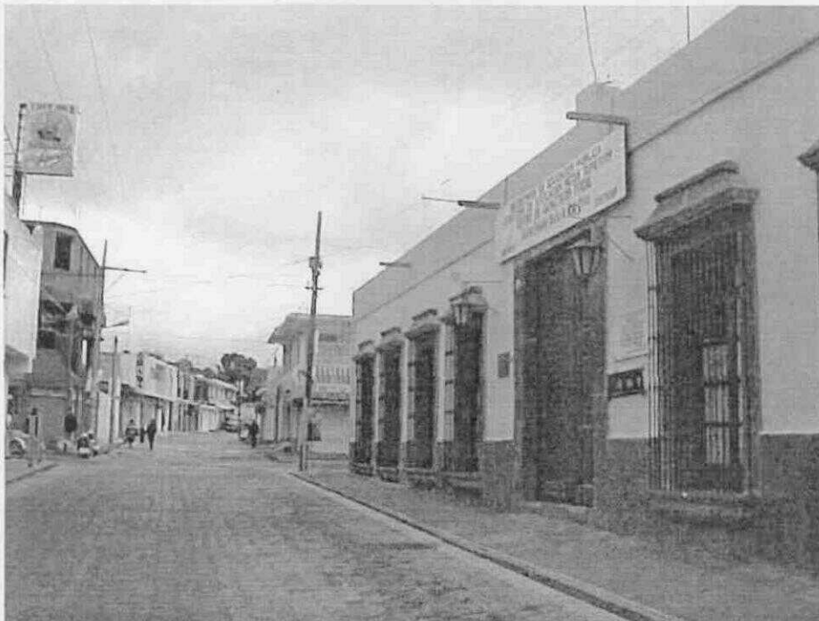
Fotografía actual: degradación de la imagen urbana por la sustitución de las edificaciones por construcciones de pésima calidad, salvo la casa Díaz Ordaz que conserva su exterior aunque en el interior ha sufrido graves transformaciones. Contaminación por cables, postes y anuncios. (Fotografía del autor, octubre 2001)
