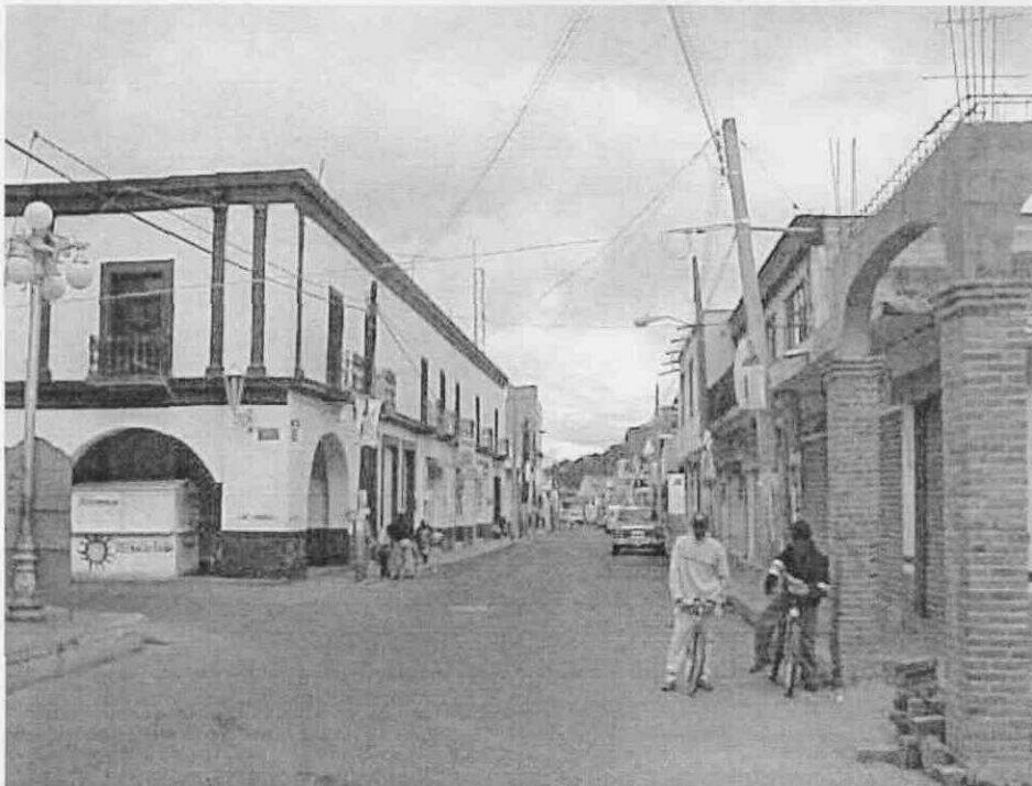
Fotografía actual: presenta graves alteraciones de la imagen de la calle, destacando por lo grave, la escenografía de la arcada que invade la mitad de la avenida, usando materiales que no son de la región. Por otro lado se puede ver el cambio de pavimento, el cambio de nivel de la plaza y la modificación de las columnas del portal. La última intervención la realizó la COPAE. (Fotografía del autor, octubre 2001)
