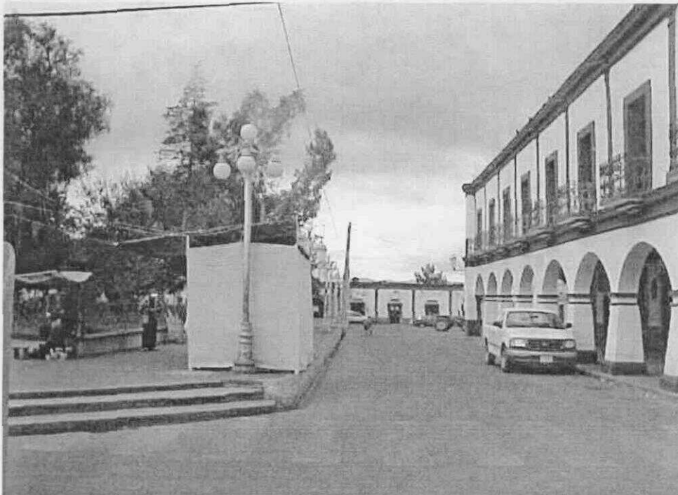
Fotografía actual: se aprecia cambio de nivel de la plaza, pérdida de la vegetación original, alteración visual por la presencia de una caseta comercial. Las columnas originales se encuentran embebidas en las pirámides truncadas de concreto que se aprecian en la foto.
