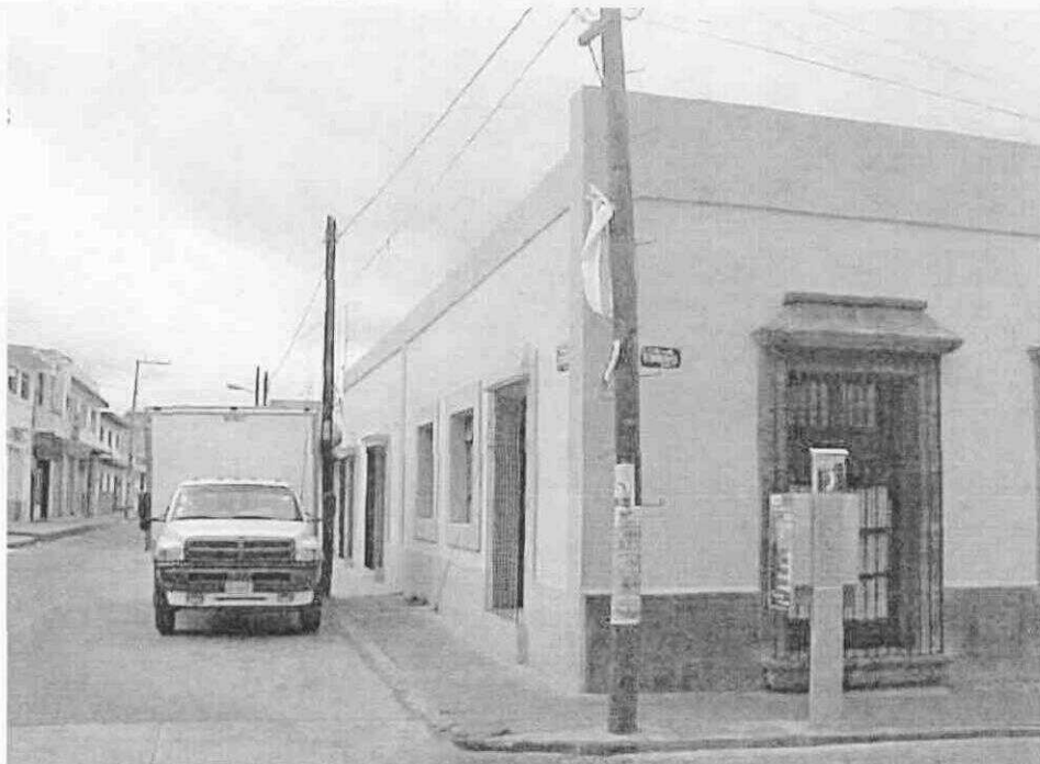
Fotografía actual: inserción de construcciones de ínfima calidad, sustitución de pavimentos, contaminación visual por cables, postes, anuncios y caseta telefónica. (Fotografía del autor, octubre 2001)
